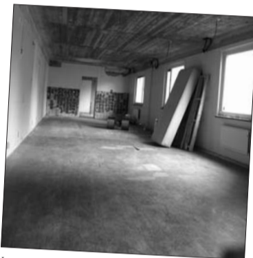
Inte så överdrivet gästvänligt än. I den här lokalen där det tidigare funnits en frisersalong bygger föreningen, under hösten 2004, två stycken nya bostadslägenheter.
